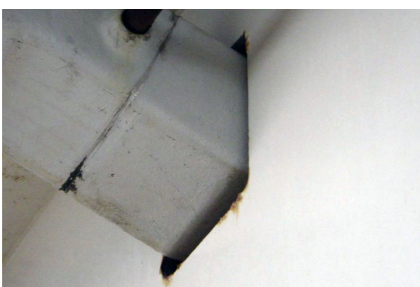
排水周りの漏水対策
