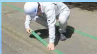
STEP1 施工範囲の養生
